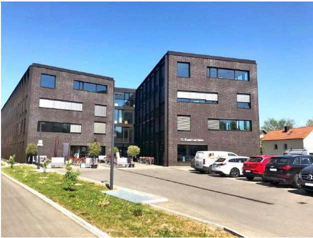
Bürogebäude: Parkstr. 40, 88212 Ravensburg
